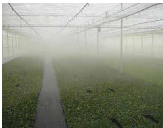
Foto 5. Răcire prin evaporare cu ajutorul unui sistem de ceață
