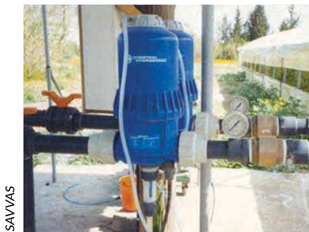
Foto 3. Furnizarea de nutrienți prin sistemul de irigare folosind un sistem de pompe de dozare pentru a injecta soluții stoc (de bază) la conducta de irigare
