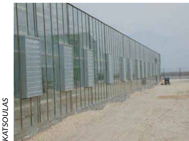
Foto 4. Ventilarea mecanică: ventilatoare utilizate pentru extragerea aerului din interiorul serei: extern (stânga) și interior (dreapta).
