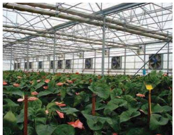
Foto 4. Ventilarea mecanică: ventilatoare utilizate pentru extragerea aerului din interiorul serei: extern (stânga) și interior (dreapta).
