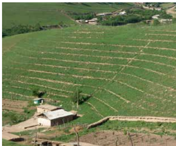
Fig. 33. Terase de contur în trepte pe versanți abrupti [44]
