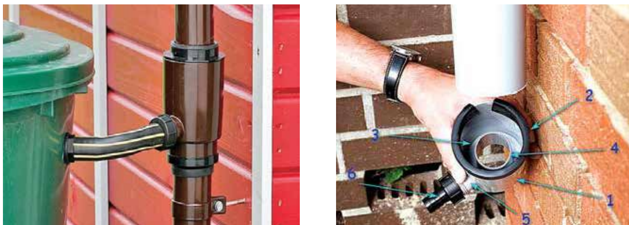
Fig. 40. Colectorul de apă din burlan direcționează apa în rezervorul de acumulare și menține nivelul fără vărsarea apei. Supapa-colector are o construcție simplă, iar instalarea ei nu prezintă dificultăți [26]
