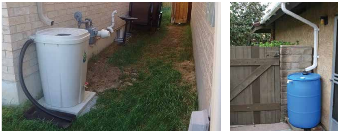
Fig. 38. Cele mai simple rezervoare de colectare a apelor de ploaie [26]
