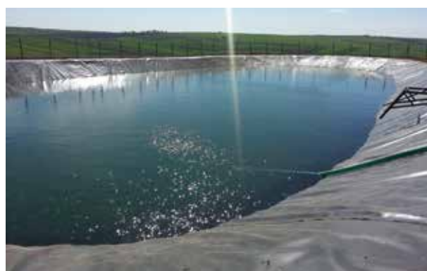
Fig. 48. Bazin de acumulare a apei de ploaie căptușit cu geomembrană
