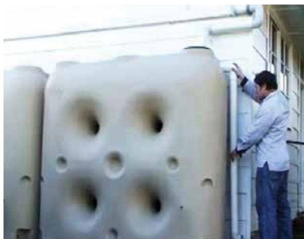
Fig. 37. Rezervoare terestre instalate de-a lungul pereților casei și care ocupă spațiu minim din curte [26]
