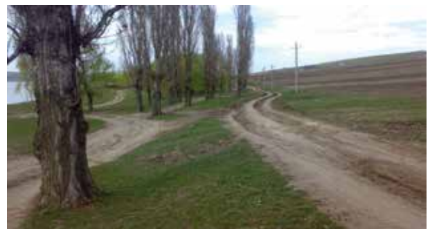
Fig. 1.6. Deteriorarea învelișului de sol de către mijloacele de transport
